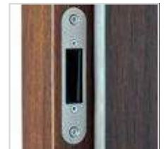
Verriegelung des Magnetschlusses, verstellbar
